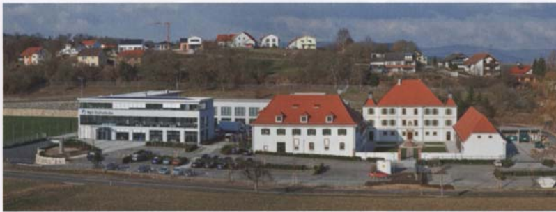
Bild 1 • Auf dem sechseinhalb Hektar großen Gelände eines ehemaligen Jagdschlusses im Hoffenheimer Nachbarort Zuzenhausen wurde das TSG-Trainings- und Geschäftszentrum mit modernster Ausstattung zur Leistungsoptimierung errichtet.
