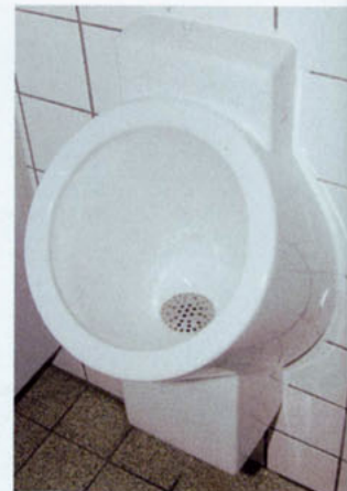
Ein Edelstahlsieb schützt die Schlauchdichtung vor Fremdkörpern.
