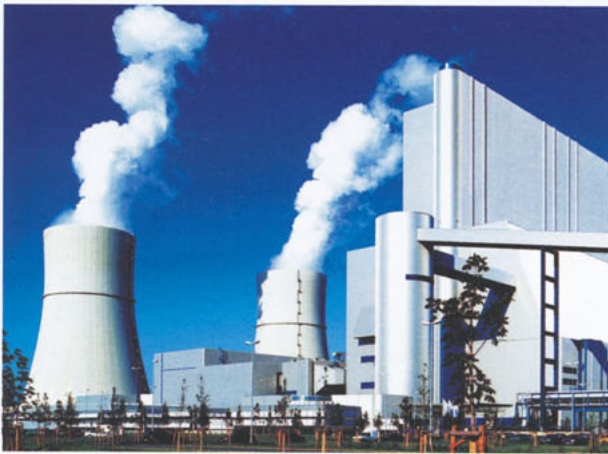
Das Kraftwerk und die Brikettfabrik „Schwarze Pumpe“ werden vom Tagebau Welzow Süd mit Braunkohle versorgt. Bei Volllast benötigt das Kraftwerk täglich rund 36.000 Tonnen Braunkohle. Foto: Vattenfall AG
