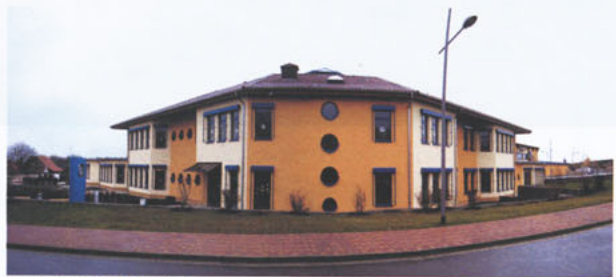
Auch die Schule ist in den neuen Ort Haidemühl umgezogen. Im Neubau können bis zu 180 Schüler der ersten bis sechsten Klasse unterrichtet werden. Foto: Keramag
