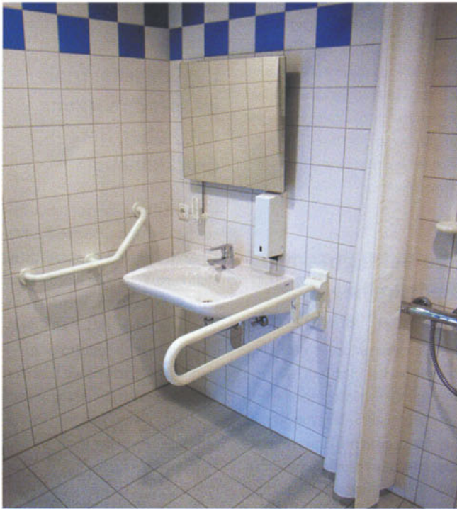
Der barrierefreie Sanitärraum der Sporthalle ist mit einem wandhängenden „Vitalis“-WC, einer bodenebenen Dusche und einem „Paracelsus“-Waschtisch ausgestattet. Die neben dem Waschtisch angebrachten Stützgriffe helfen dem Nutzer beim Heranziehen an den Waschtisch oder beim Aufrichten aus einem Rollstuhl. Foto: Keramag
