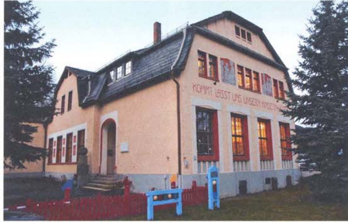
Bild 1 • Seit 1908 befindet sich in diesem Gebäude ein Kindergarten, der dem Pädagogen Friedrich Fröbel gewidmet ist.
