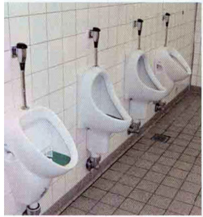
Vor dem Umbau ... ... waren auf den Herrentoiletten Urinale vorhanden, die teilweise noch aus der Bauzeit des Mensa-Gebäudes stammten. Einige waren in den zurückliegenden Jahren schon durch „Aller“-Urinale von Keramag ersetzt worden
