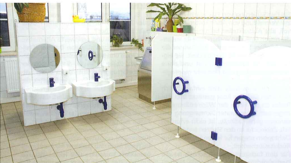
Die speziellen Kinder-WCs sind in der KiTa „Regenbogen“ in kindgerechten Kabinen untergebracht, deren geringe Bauhöhe eine problemlose Beaufsichtigung durch das Personal ermöglicht. An der Farbgestaltung der Beschläge und der Formgebung der Kabinentüren können die Kinder „ihren“ Sanitärraum erkennen.
